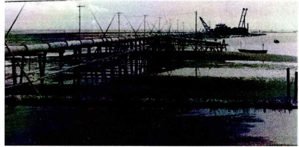
埋立工事風景 遠浅海岸部の砂をポンプで送る
